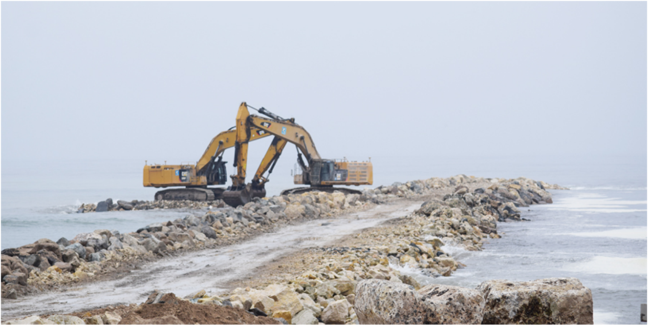
Lucrările de lărgire a plajelor din sudul litoralului
