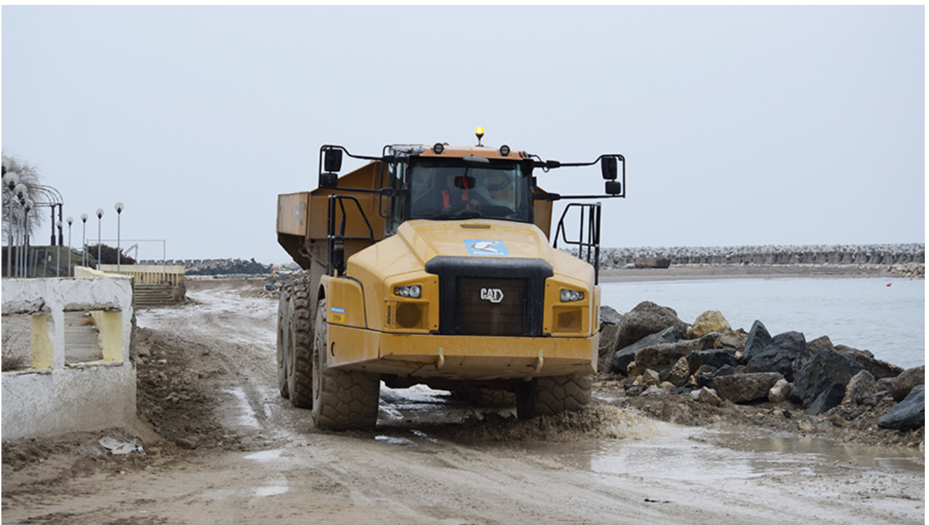
Lucrările de lărgire a plajelor din sudul litoralului
