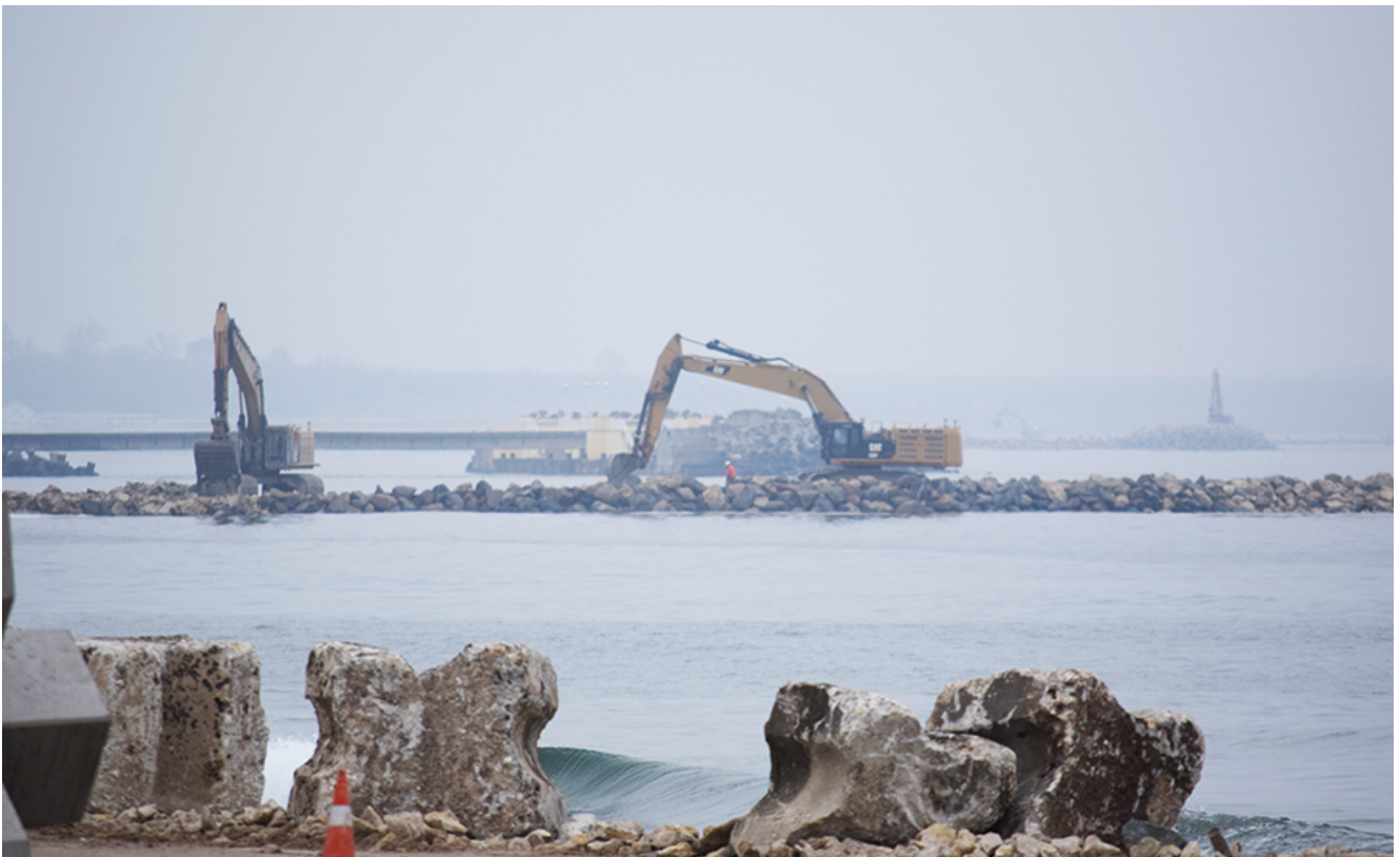
Lucrările de lărgire a plajelor din sudul litoralului
