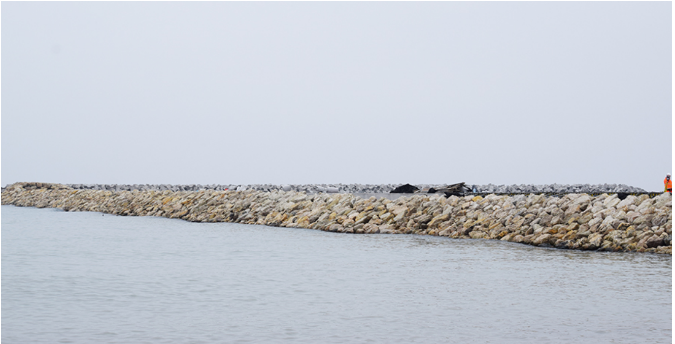
Lucrările de lărgire a plajelor din sudul litoralului
