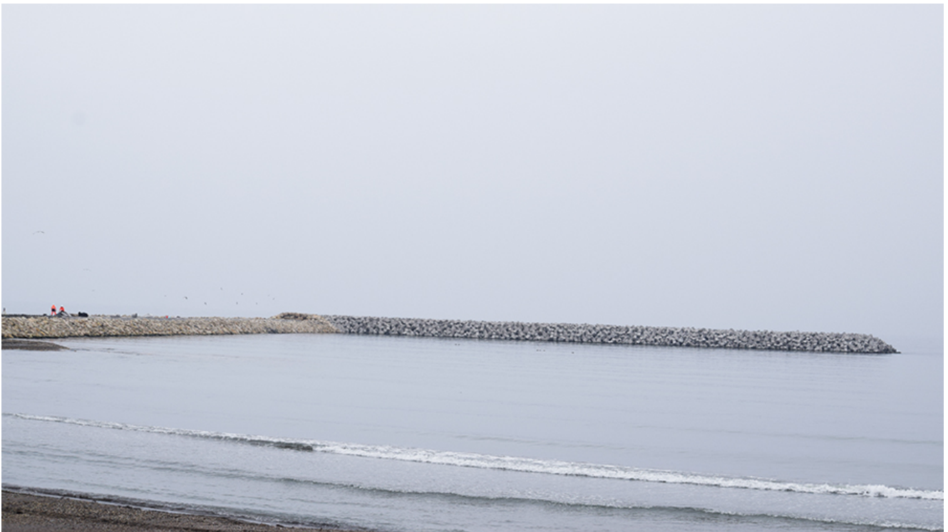
Lucrările de lărgire a plajelor din sudul litoralului
