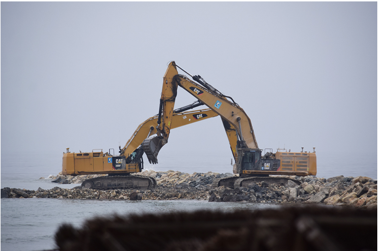
Lucrările de lărgire a plajelor din sudul litoralului
