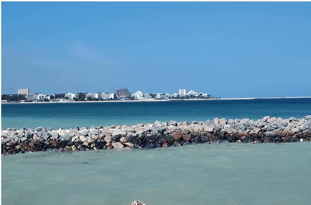
Reabilitarea digurilor din Saturn
