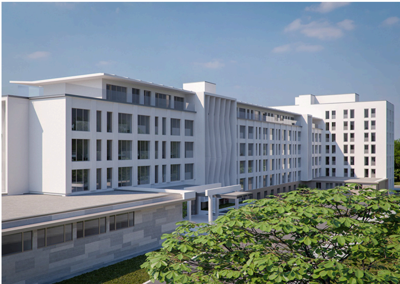
Sanatoriul Balnear și de Recuperare Mangalia
