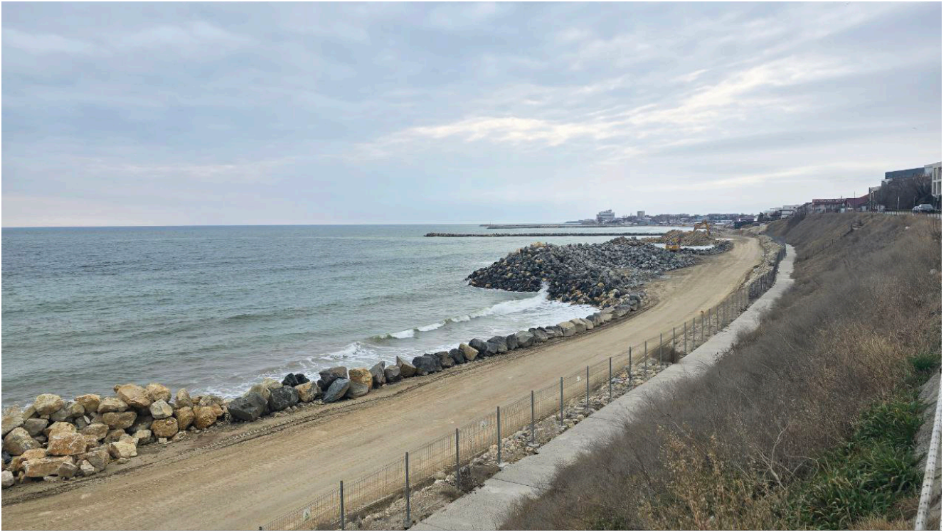
Lucrările de refacere a plajelor și digurilor la Costinești
