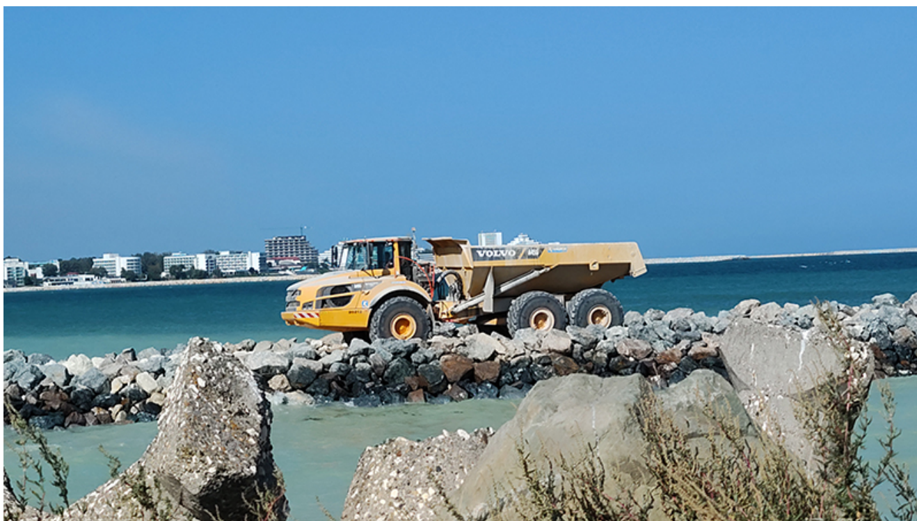
Reabilitarea digurilor din Saturn
