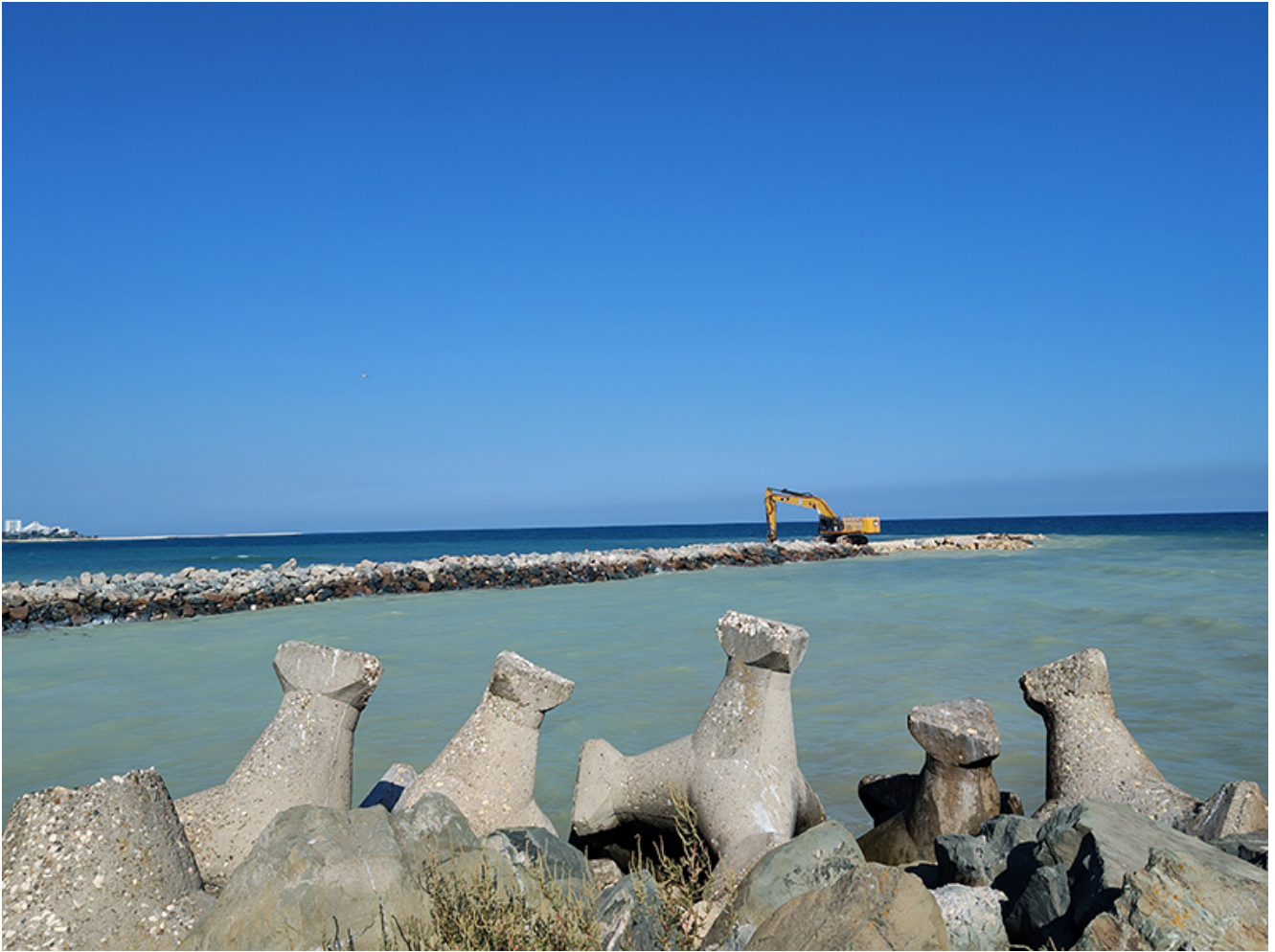
Reabilitarea digurilor din Saturn
