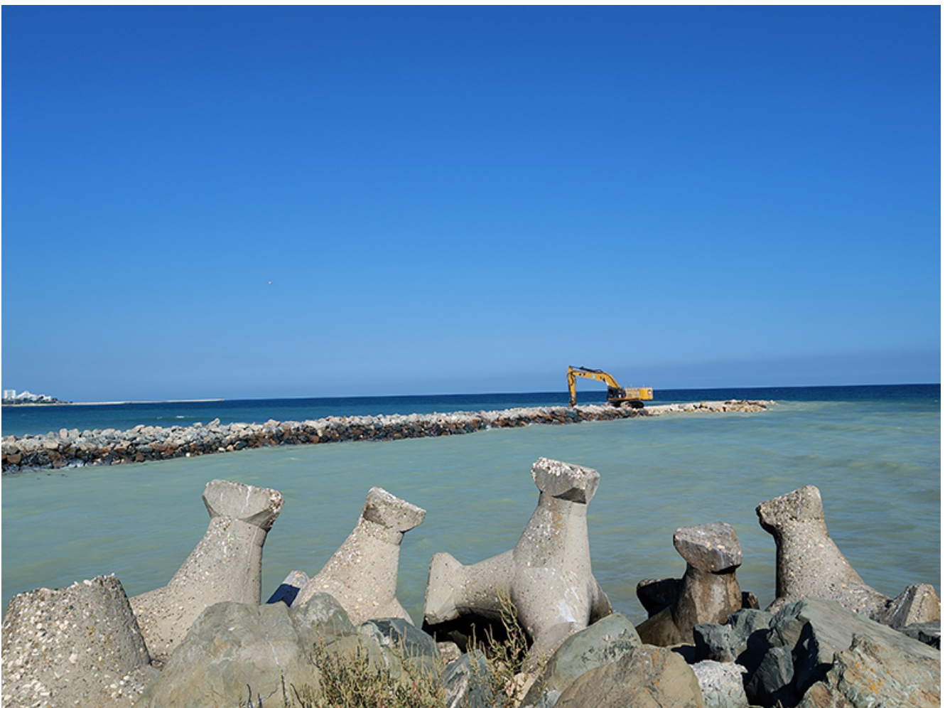
Reabilitarea digurilor din Saturn
