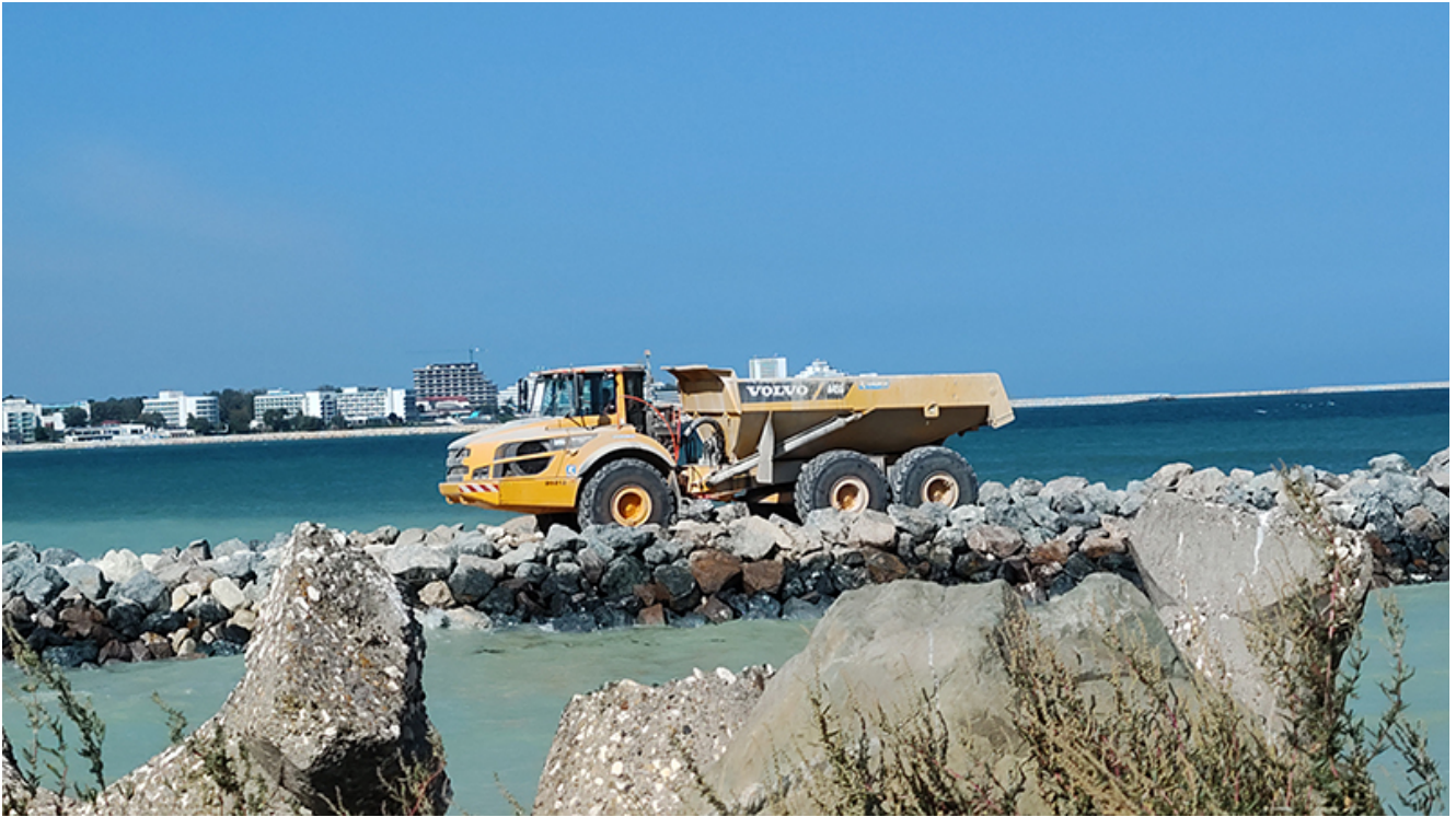
Reabilitarea digurilor din Saturn
