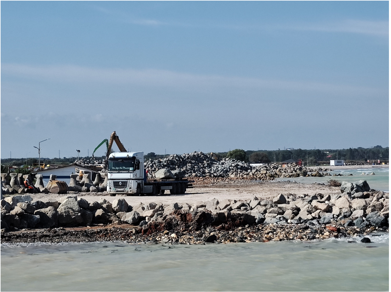
Reabilitarea digurilor din Saturn
