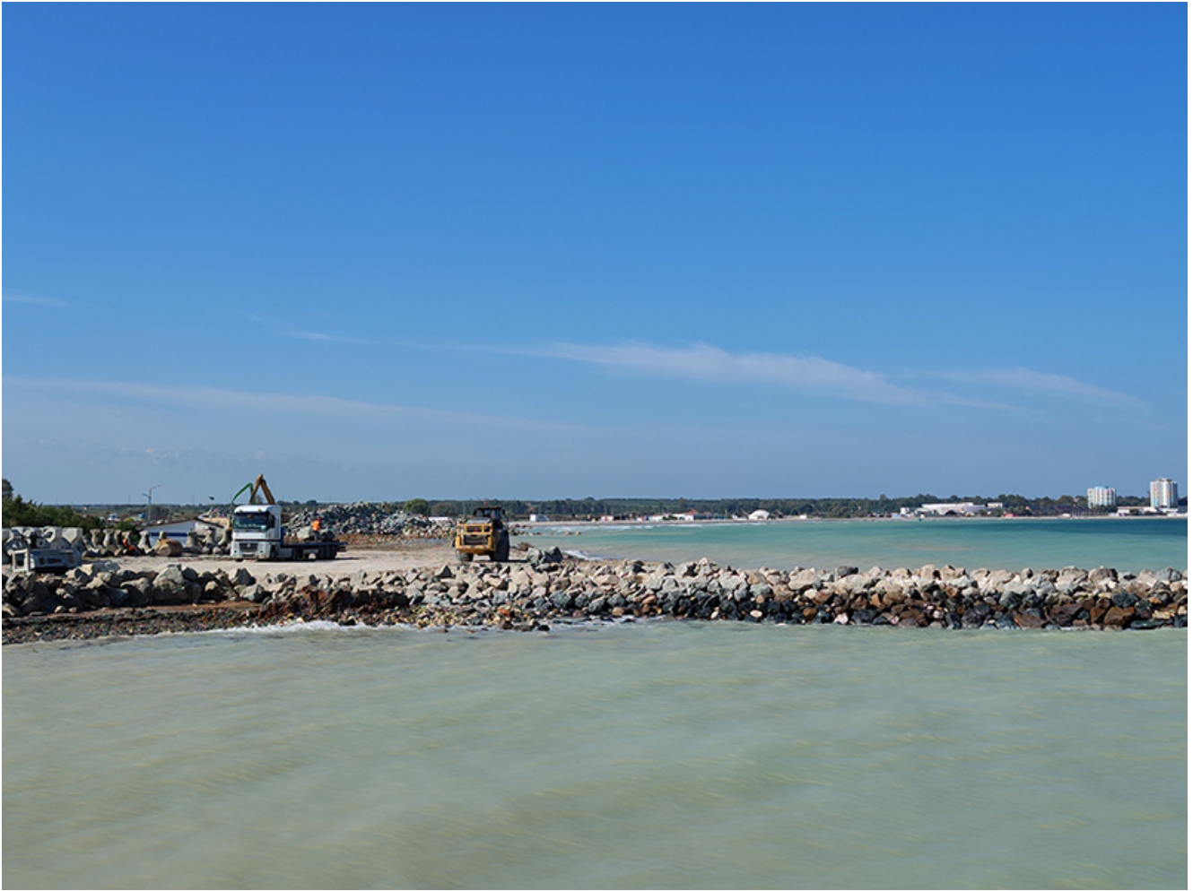
Reabilitarea digurilor din Saturn
