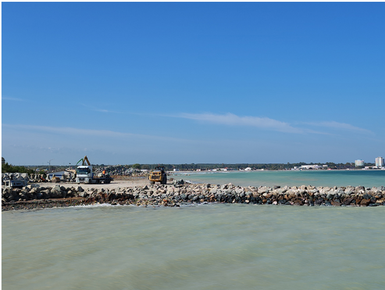
Reabilitarea digurilor din Saturn
