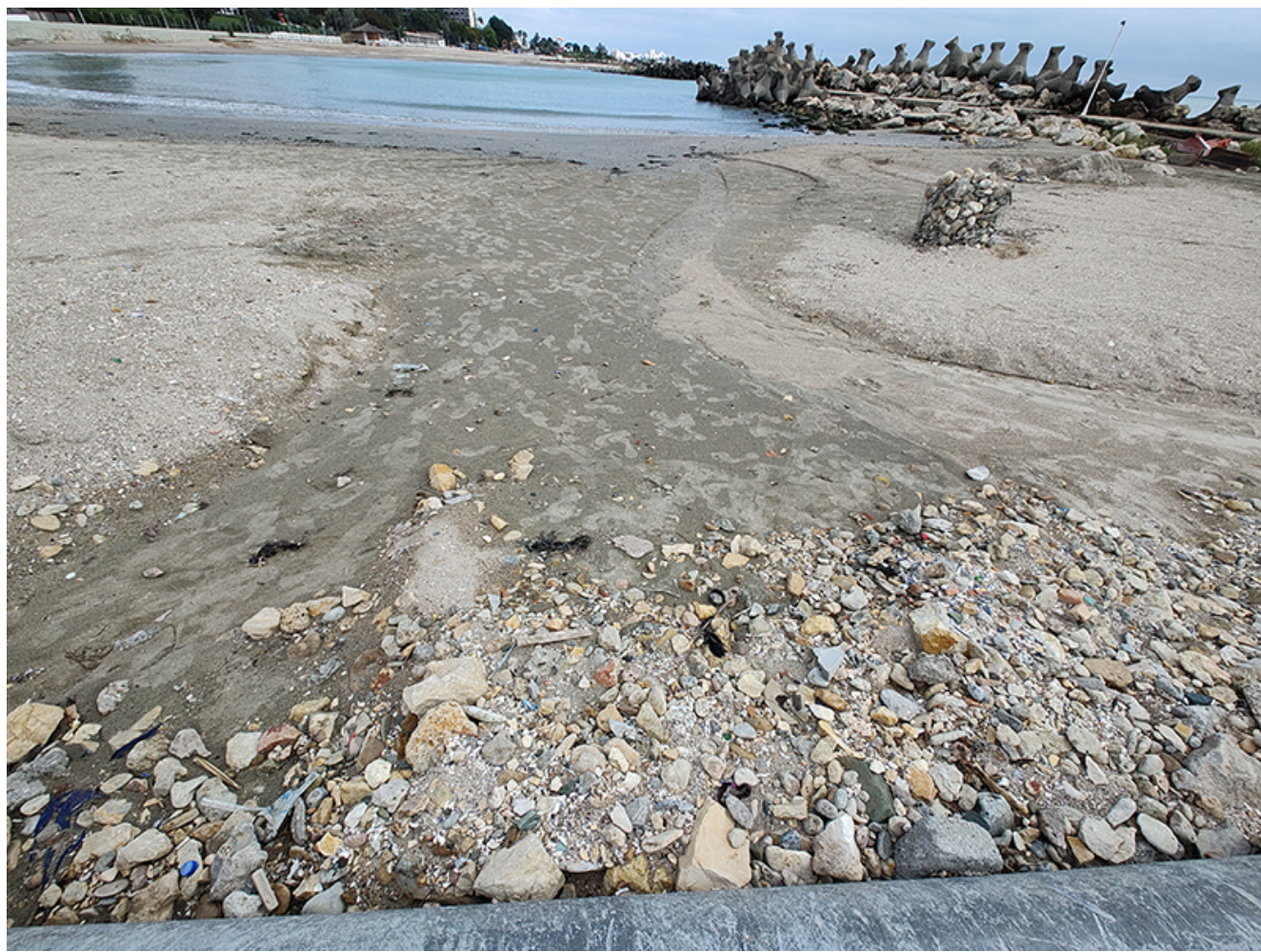
Plaje afectate de inundații
