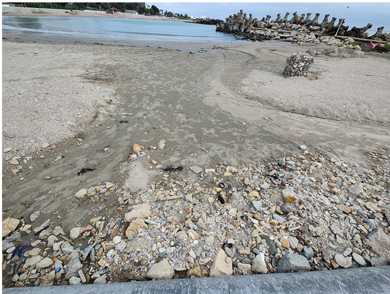
Plaje afectate de inundații
