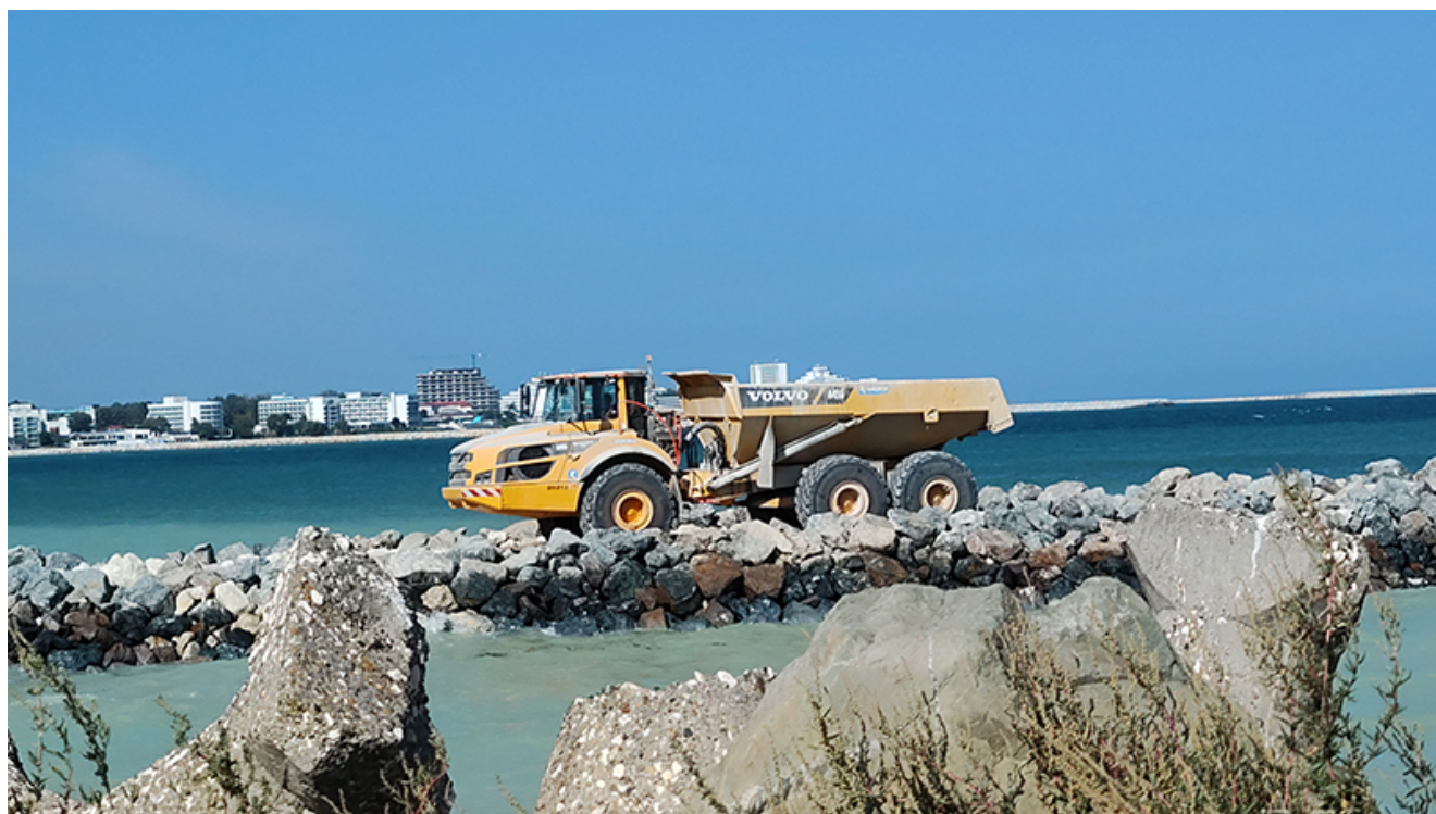
Reabilitarea digurilor din Saturn
