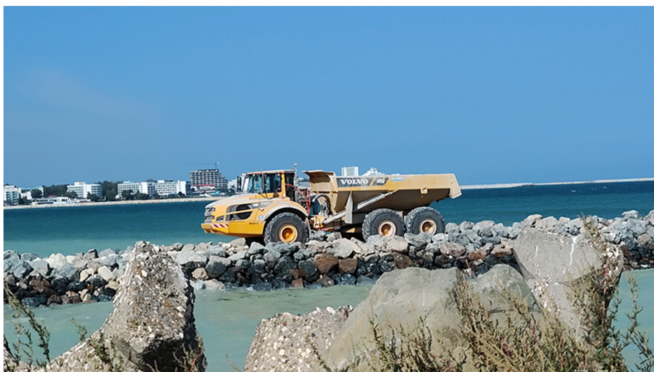
Reabilitarea digurilor din Saturn
