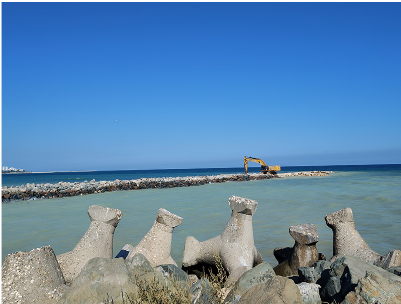
Reabilitarea digurilor din Saturn
