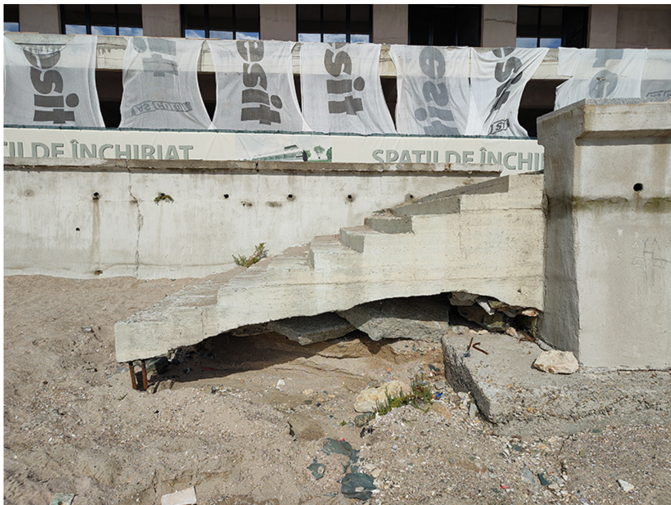
Plaje afectate de inundații
