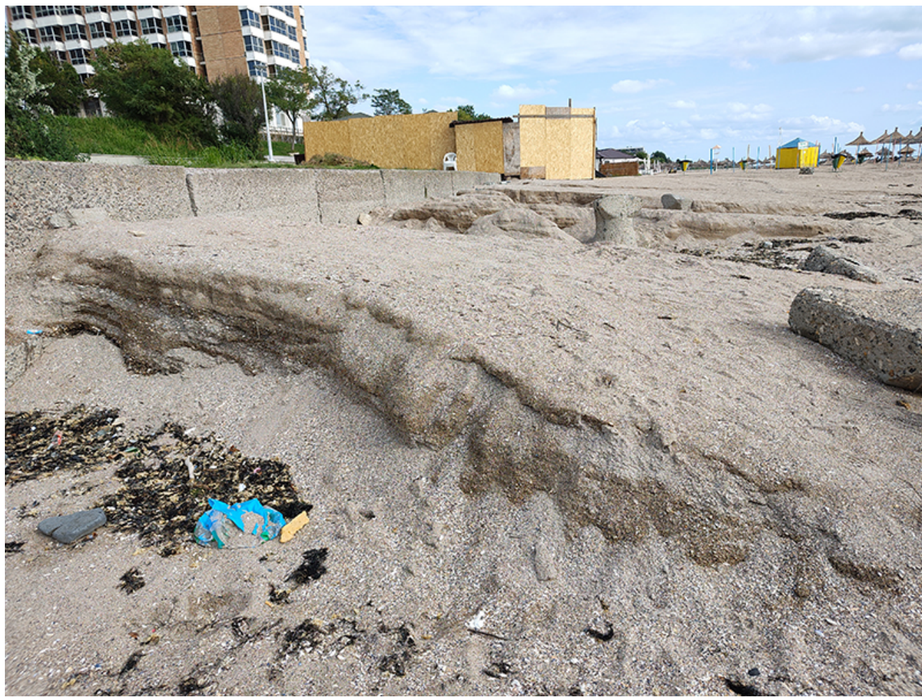
Plaje afectate de inundații
