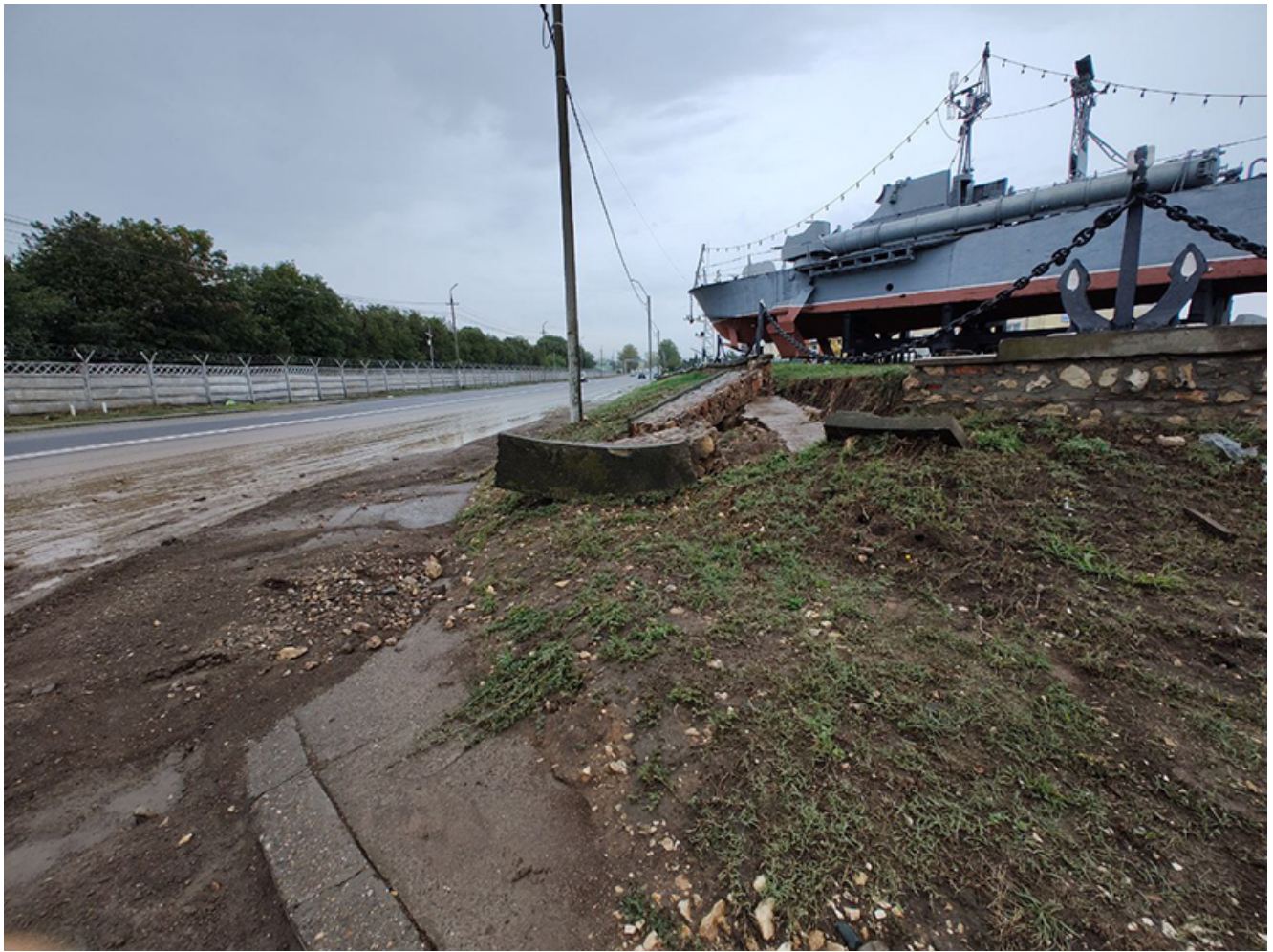
Gardul cimitirului s-a prăbușit
