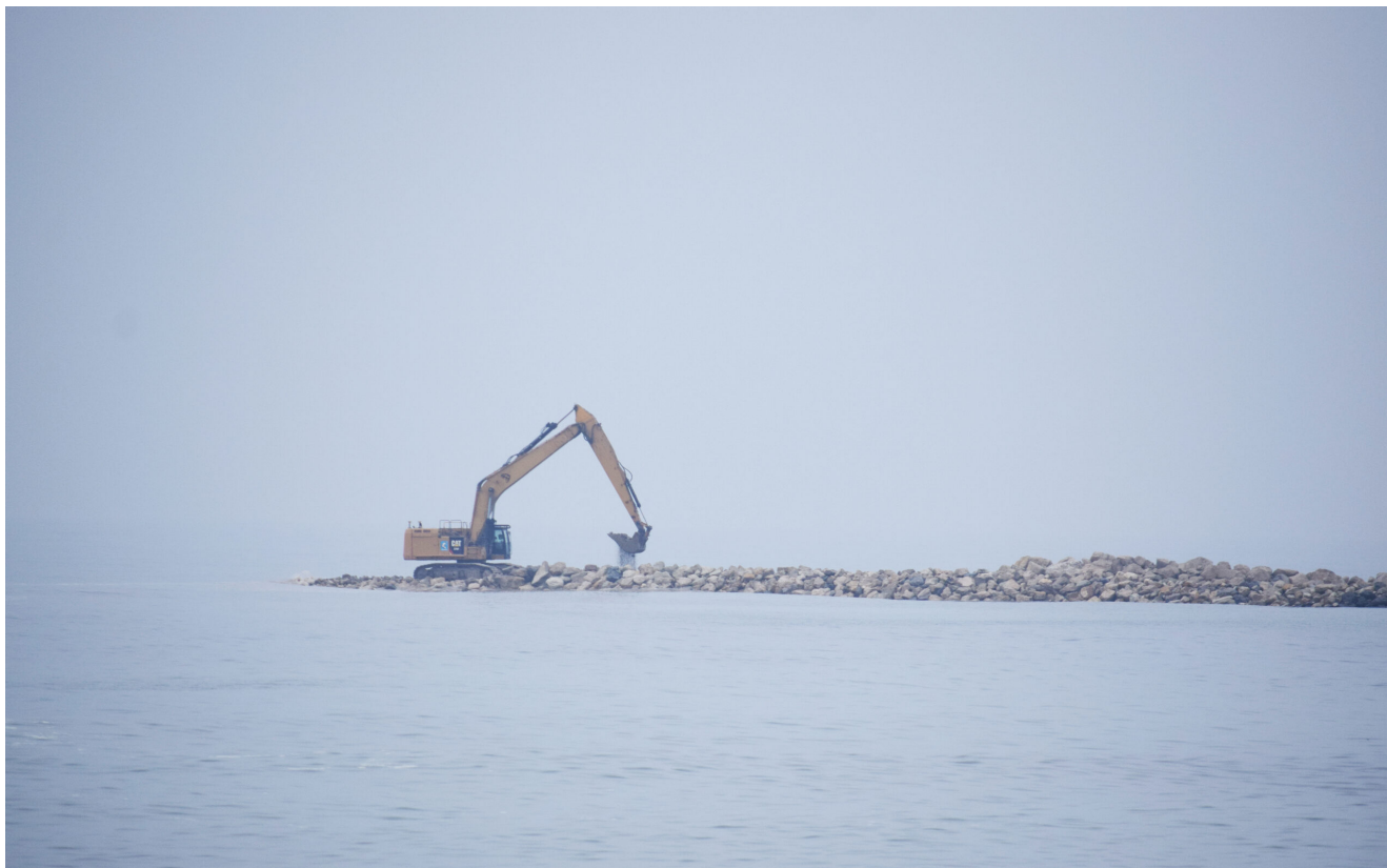
Lucrările de lărgire a plajelor din sudul litoralului
