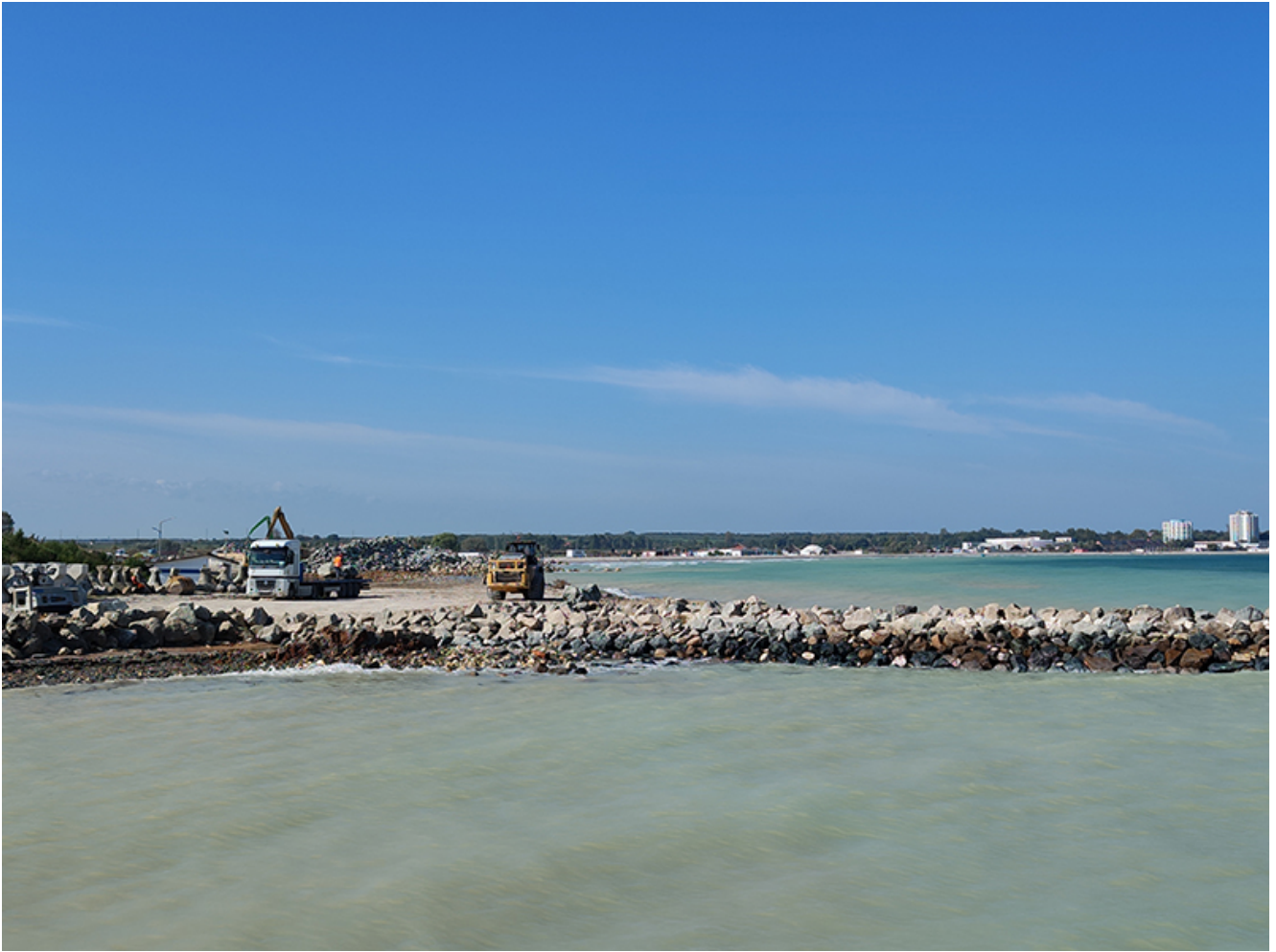
Reabilitarea digurilor din Saturn
