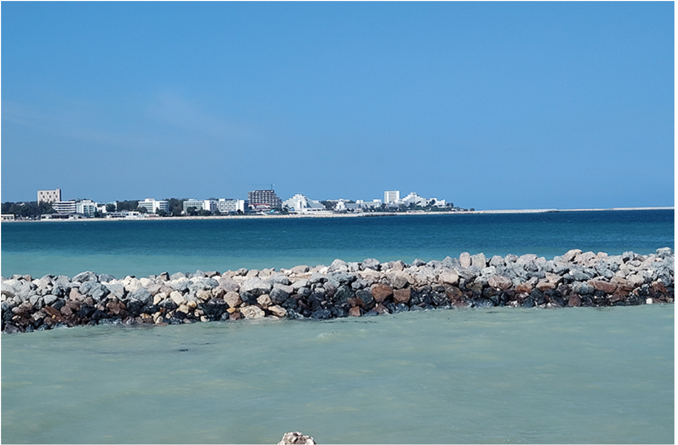
Reabilitarea digurilor din Saturn
