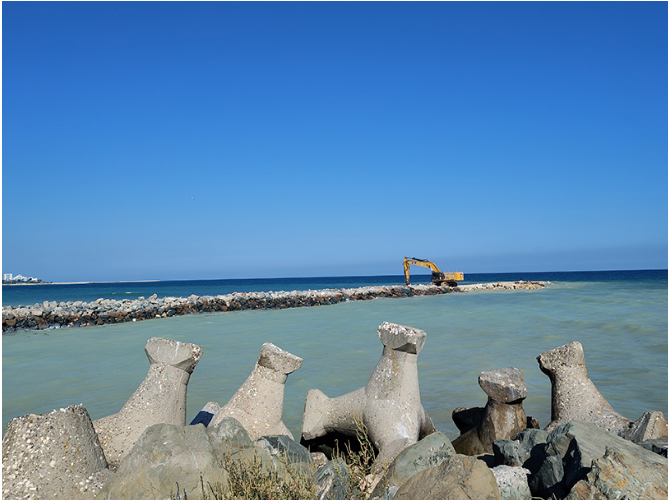
Reabilitarea digurilor din Saturn
