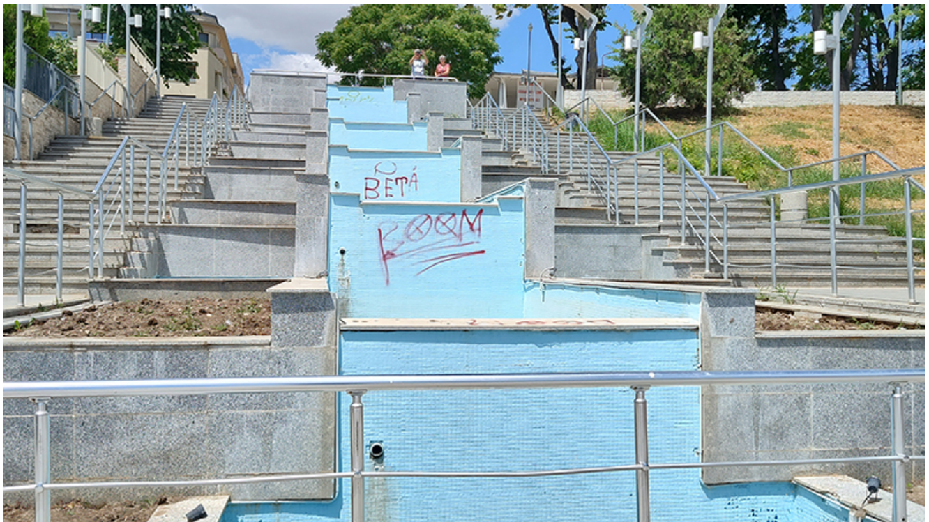
Fântâna de pe faleză a reintrat în COLAPS
