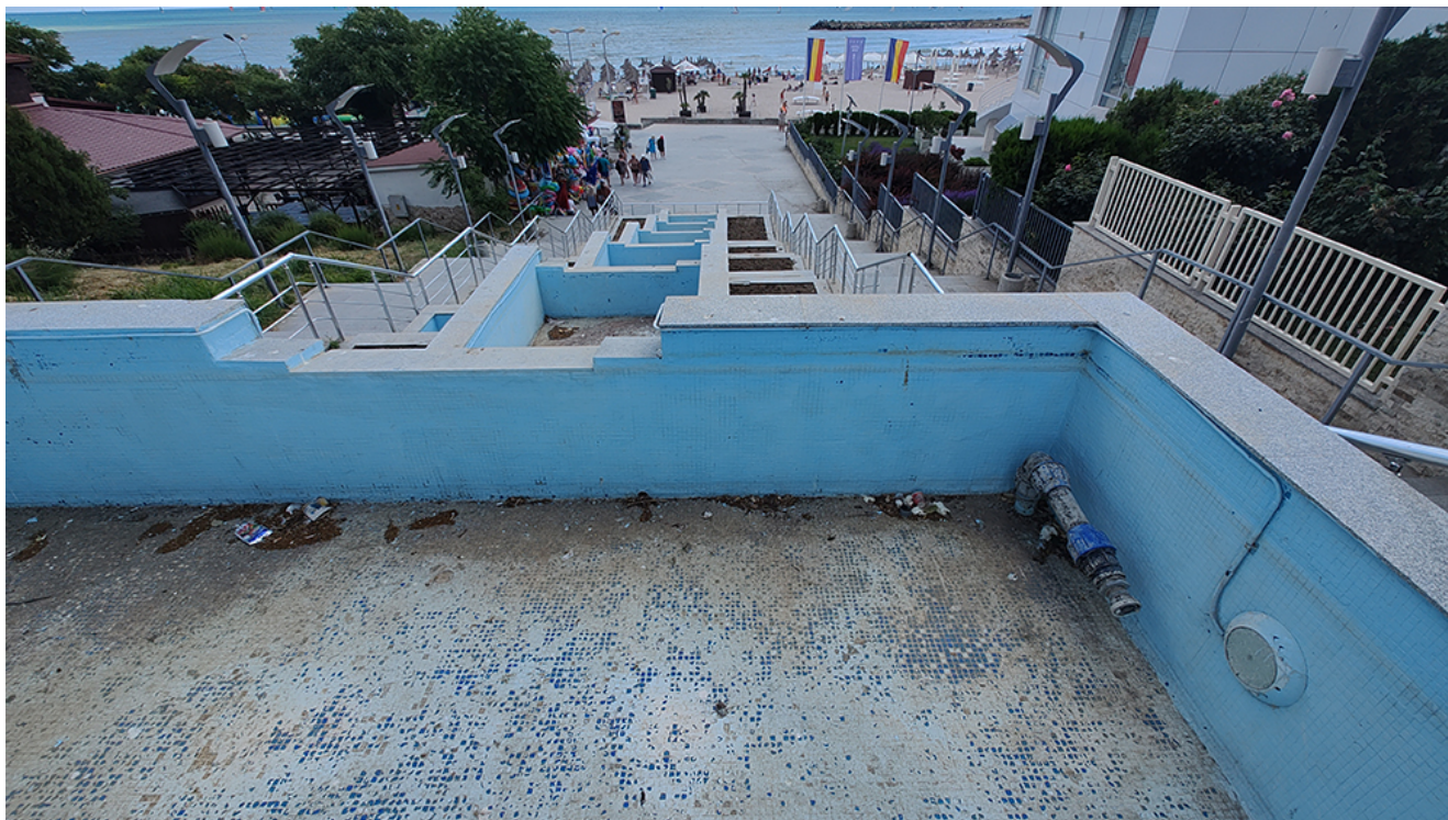
Fântâna de pe faleză a reintrat în COLAPS
