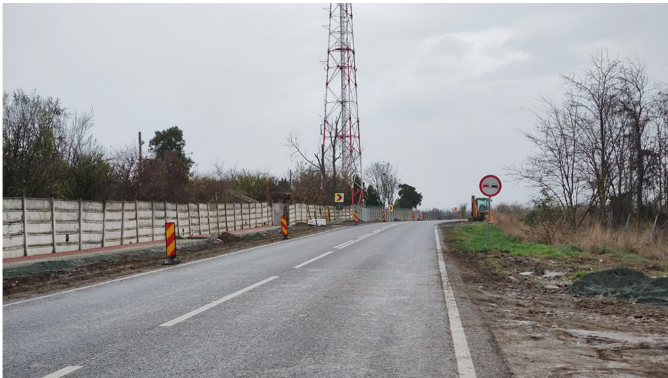
Continuă lucrările la trotuarul dintre 2 Mai și Vama Veche
