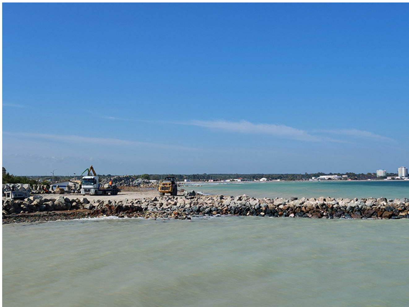
Reabilitarea digurilor din Saturn
