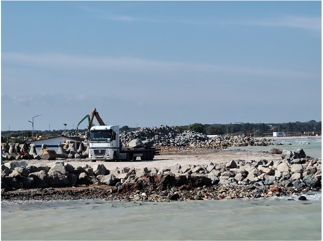
Reabilitarea digurilor din Saturn
