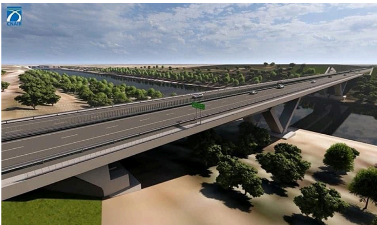
construcția Alternativei Techirghiol
