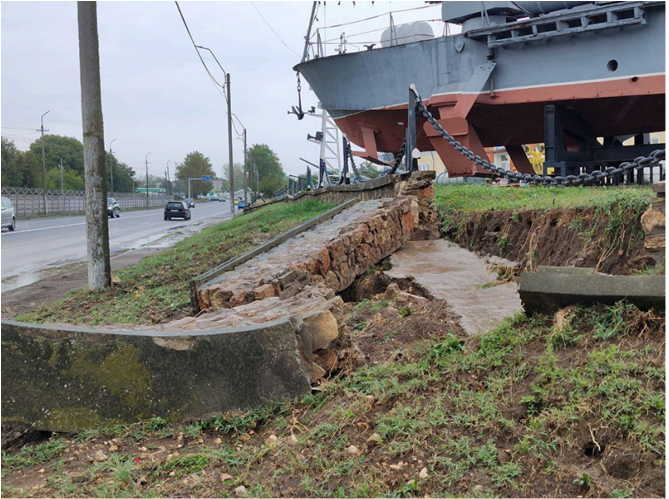
Gardul cimitirului s-a prăbușit
