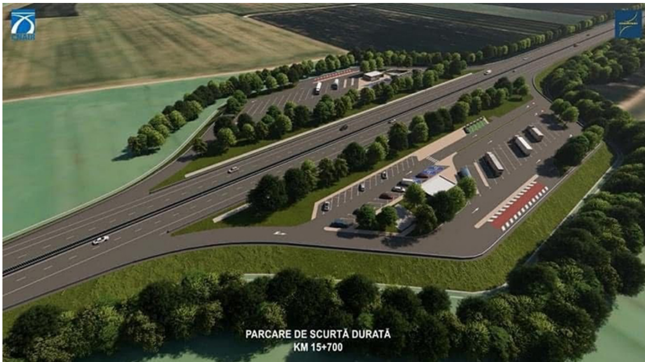
construcția Alternativei Techirghiol
