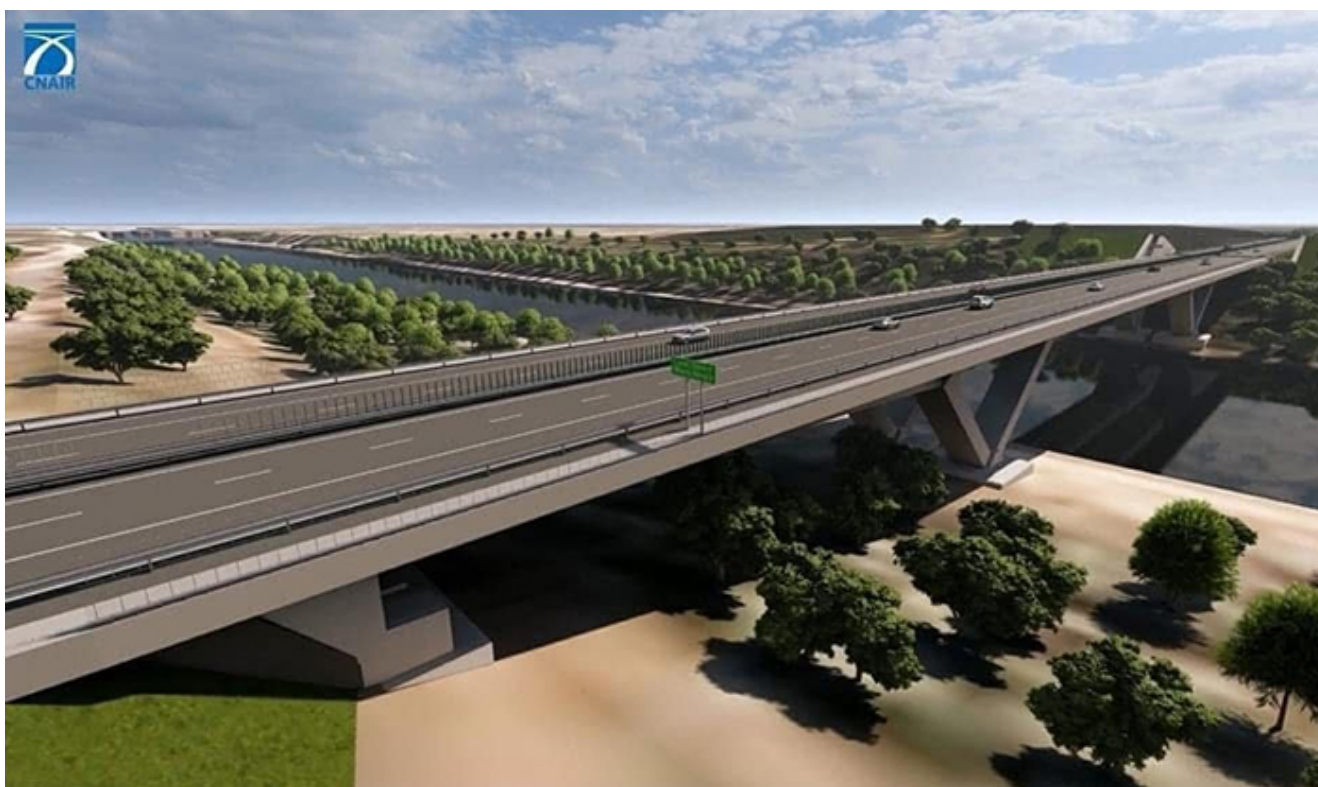
construcția Alternativei Techirghiol
