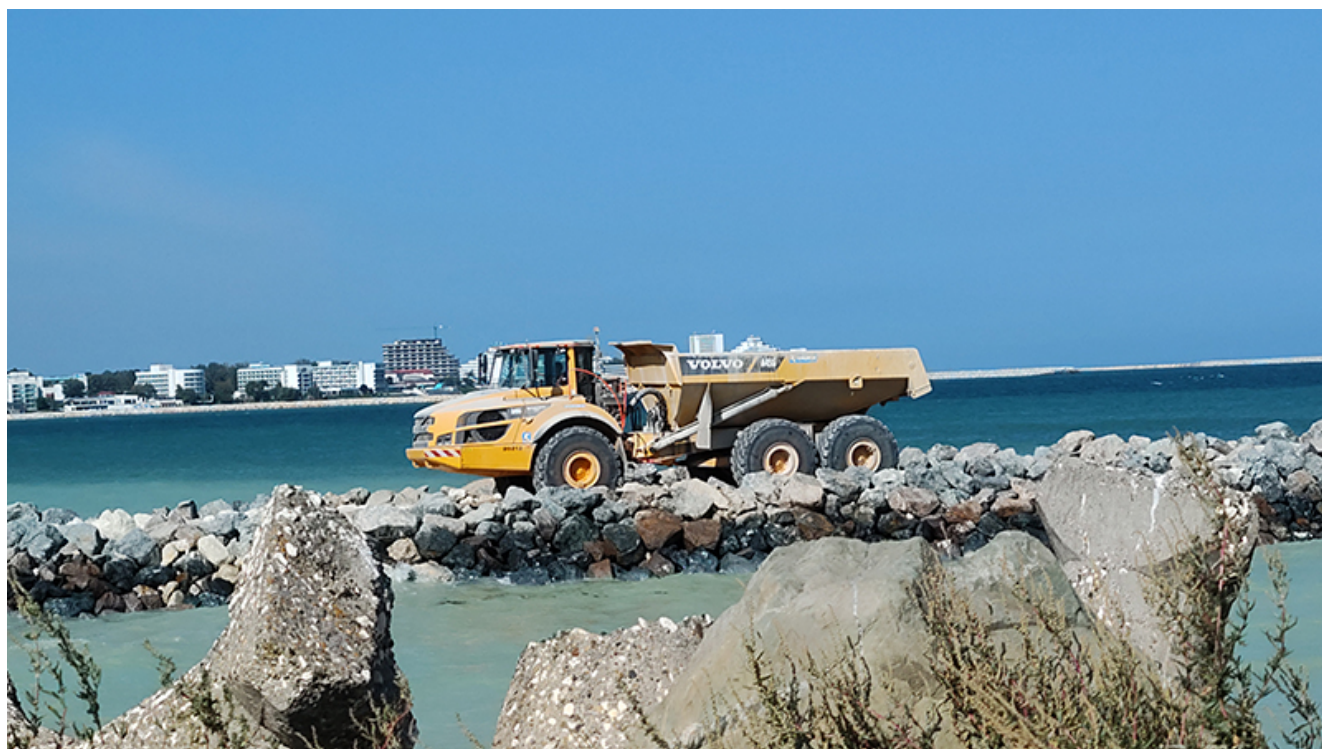
Reabilitarea digurilor din Saturn
