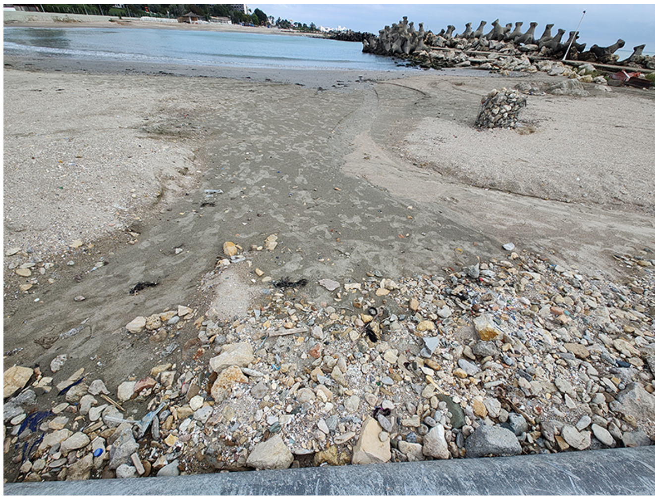
Plaje afectate de inundații
