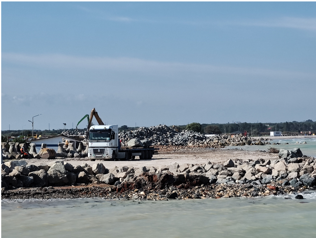
Reabilitarea digurilor din Saturn
