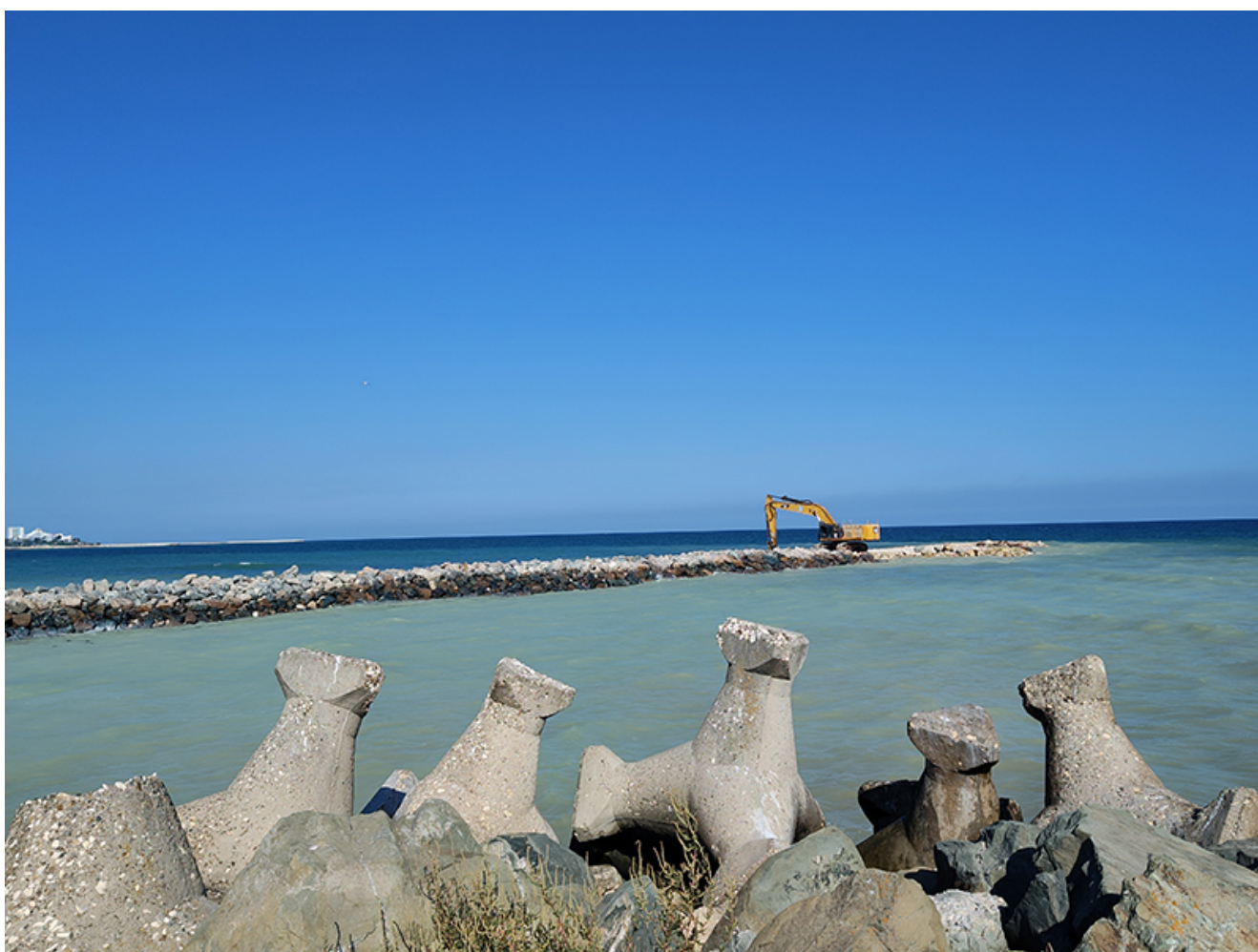
Reabilitarea digurilor din Saturn
