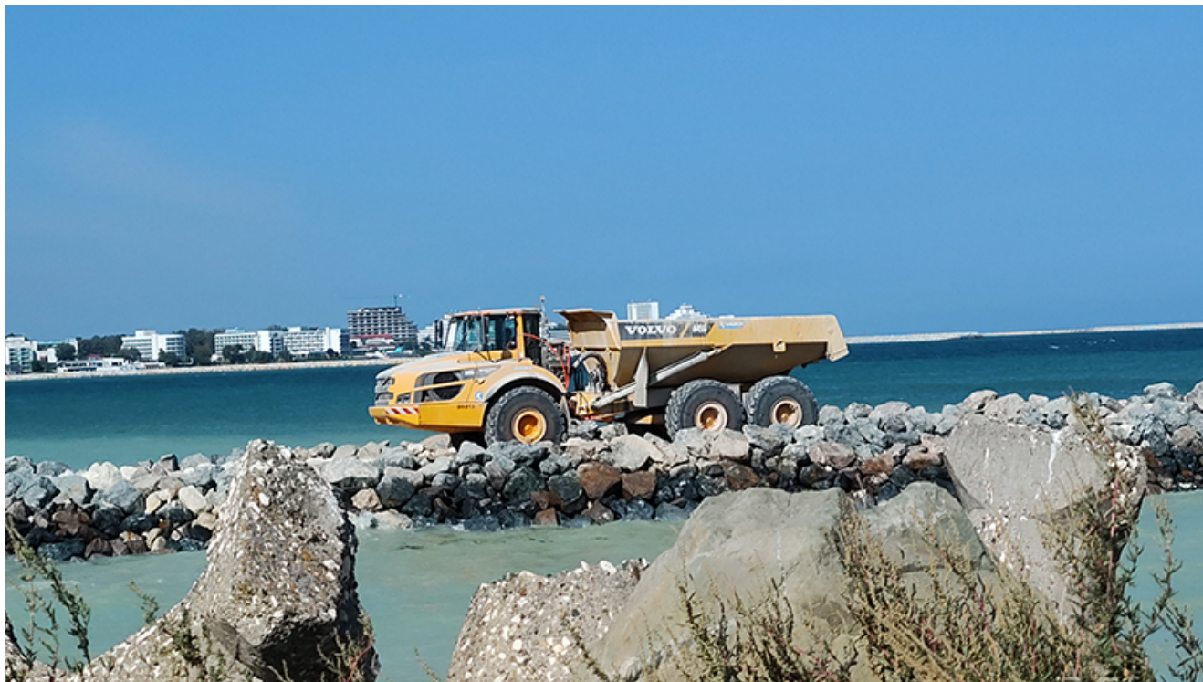
Reabilitarea digurilor din Saturn
