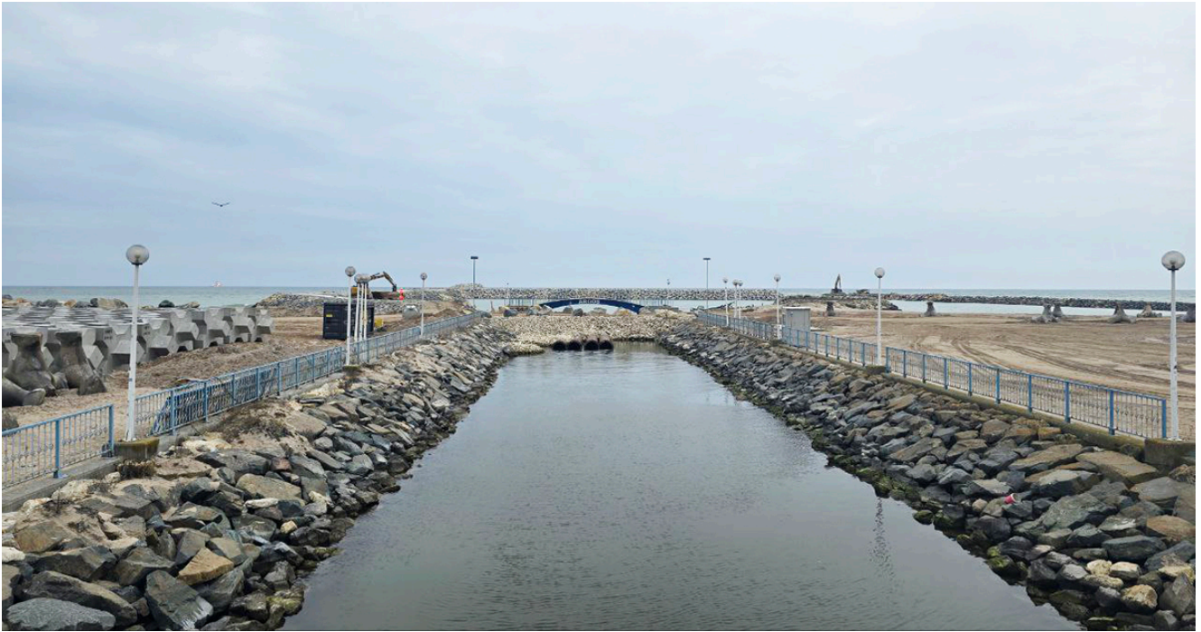
Lucrările de refacere a plajelor și digurilor la Costinești
