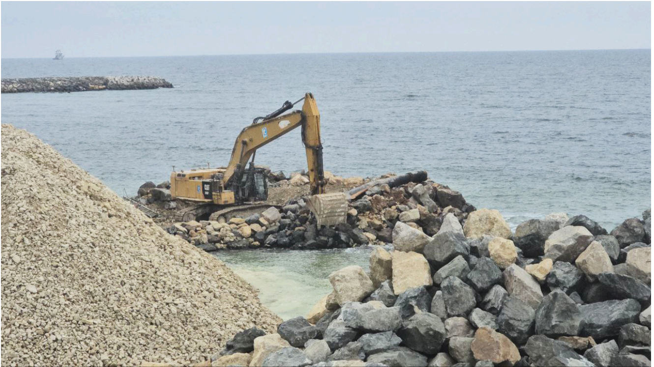
Lucrările de refacere a plajelor și digurilor la Costinești
