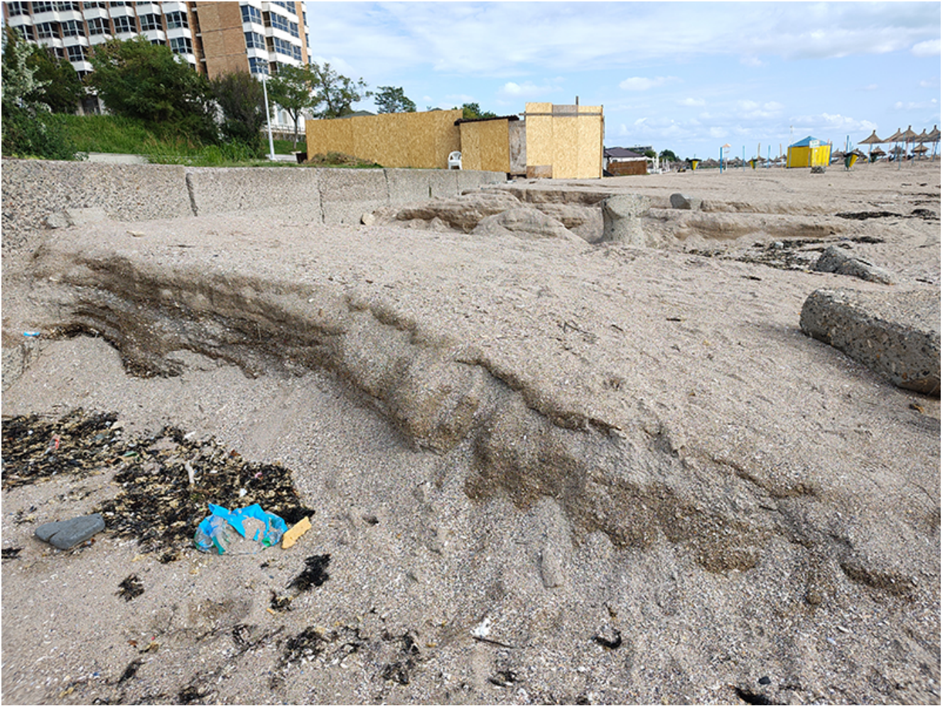
Plaje afectate de inundații
