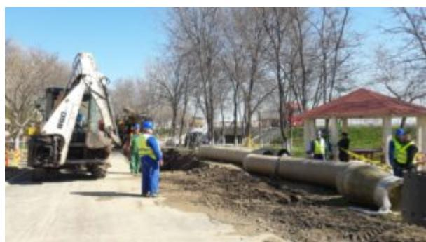
Pentru remedierea unei avarii la conducta de transport ape uzate menajere, cu diametrul de 800 mm, din zona Penny Market – Năvodari, SC RAJA SA execută, pe tot parcursul lunii aprilie 2018, lucrări de înlocuire a unui segment al instalației, pe o lungime de 90 metri. Pentru realizarea lucrărilor este necesară decopertarea zonei din parcul aflat în apropierea magazinului Penny, pe tronsonul delimitat de străzile Mării și Rândunelelor. Conducta de
