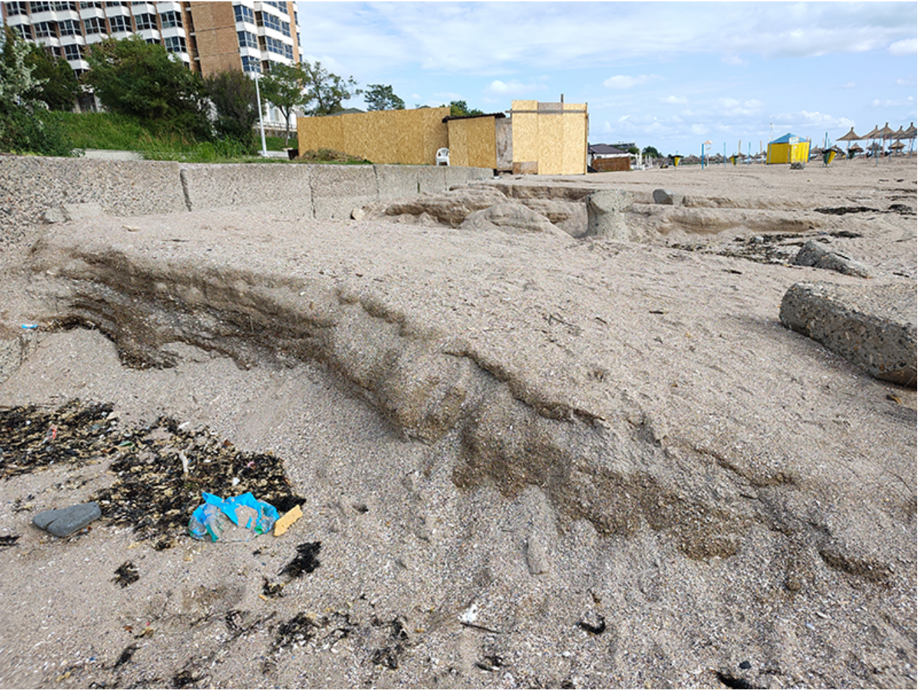
Plaje afectate de inundații
