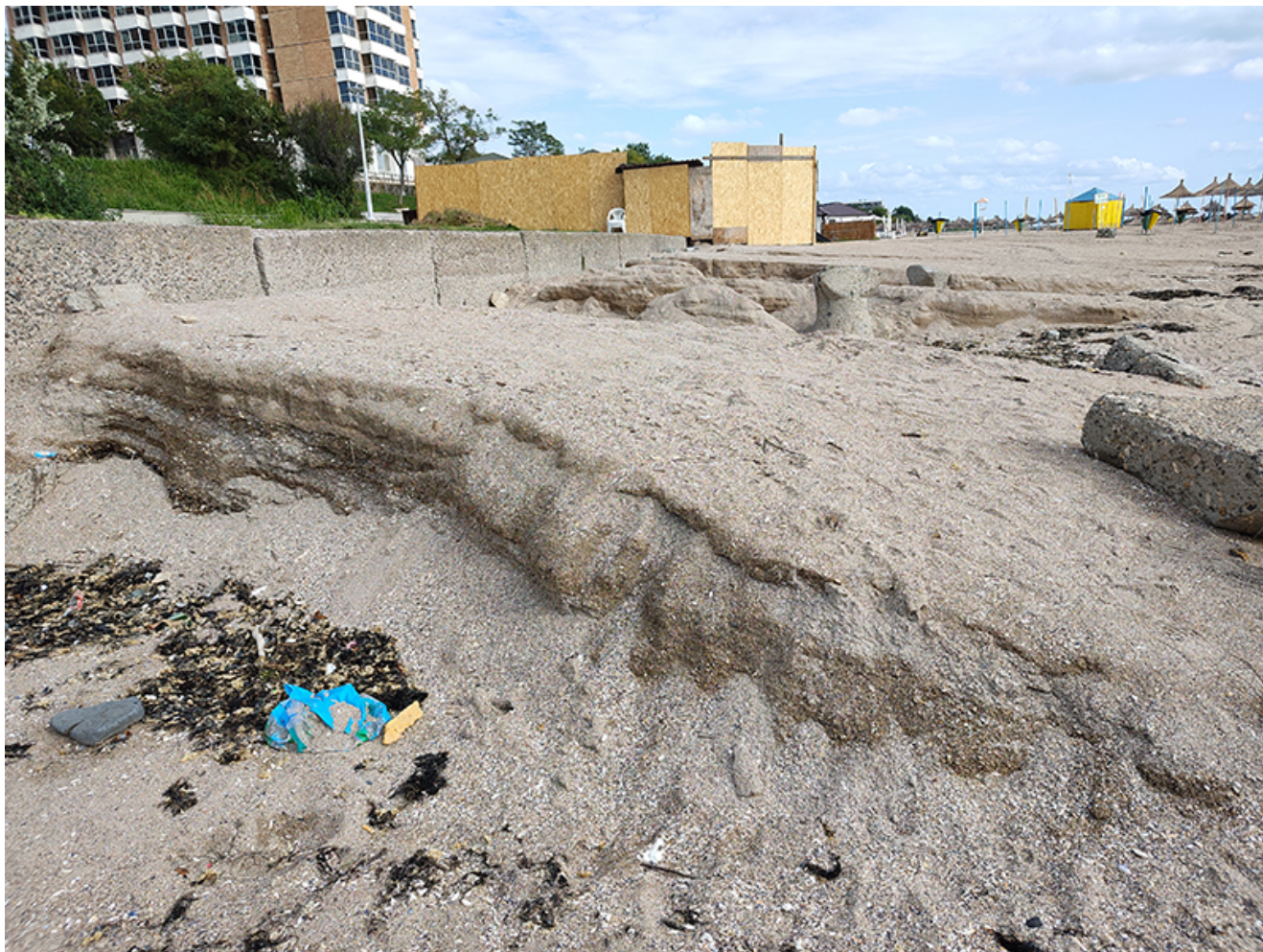
Plaje afectate de inundații
