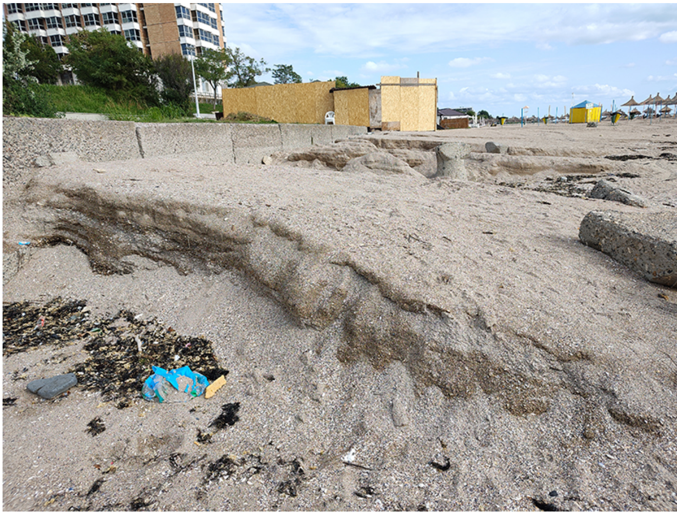
Plaje afectate de inundații
